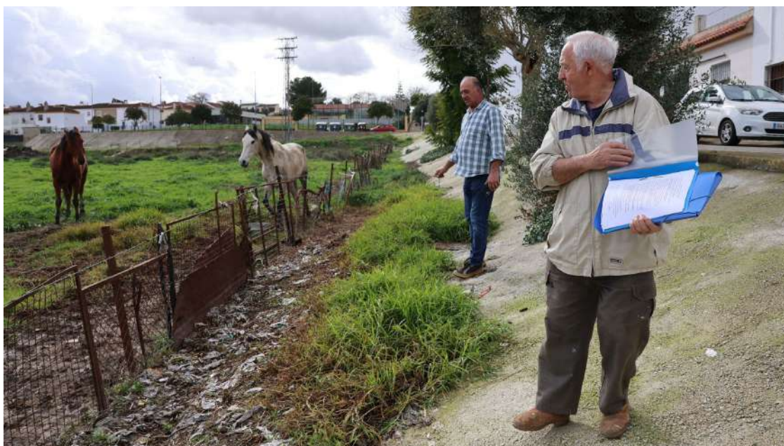
Javier Lezama y Luis Pérez, vecinos de Estella, al lado de una zona que se inunda de aguas fecales con las lluvias.
